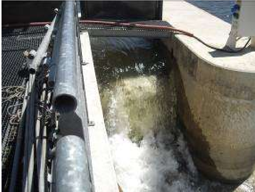
Figure 1 : Exemple de déversoir rectangulaire dénoyé.
