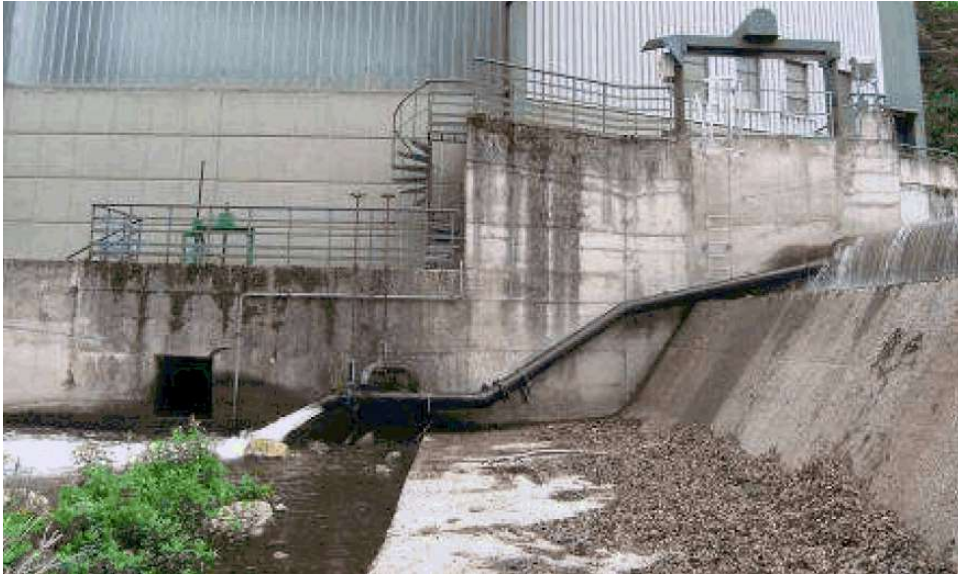
Figure 17 : Exemple de conduite en charge par syphon.
