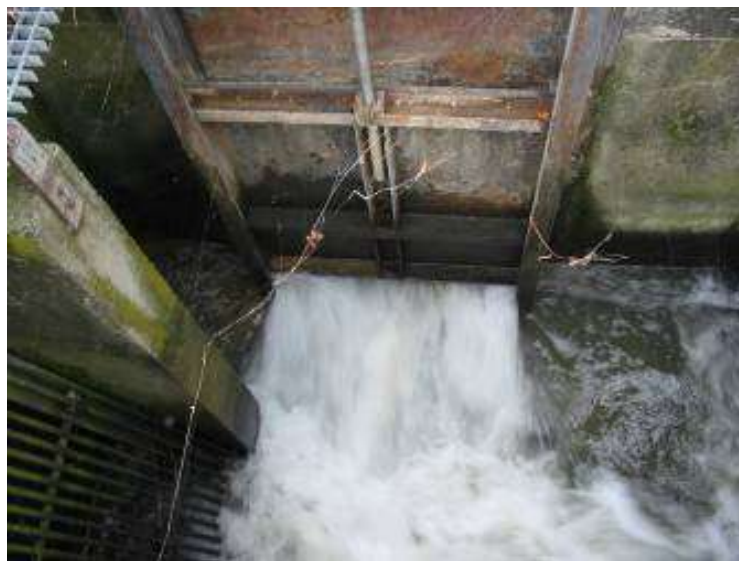
Figure 14 : Exemple d'écoulement sous une vanne de fond
