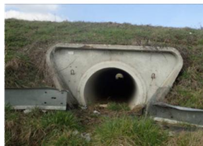
Photos 38 à 40 : A gauche, tunnel sous chaussée de type II b (batrachoduc de Gaumont) ;
