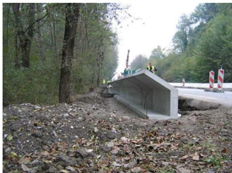
Photo 33 : Collecteur préfabriqué en béton avec corniche anti-escalade ou bavolet conséquent « en prévision » de la Rainette arboricole sur le site du Cheylas (Source : © H. Coffre, LPO 38)
