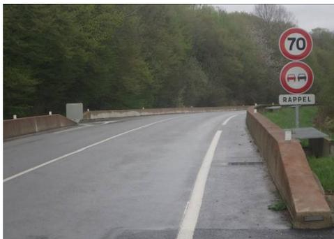
Photo 32 : Installation standard ou collecteur en L préfabriqué en béton avec une petite corniche en béton. Source : Le Lac du Der (Source : © A. Morand, Cerema Est)
