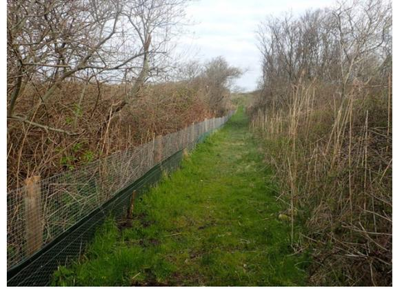
Photo 22 : Un exemple de dispositif quasi-pérenne sur la RD 940 - dunes de Slack et site du Conservatoire (Atelier Chantier Insertion Rivages Propres & Eden 62) : barrière permanente d'une centaine de mètres des deux côtés de la voie (RD 940) avec collecte des amphibiens 6/12 mois (Source : © A. Morand, Cerema Est)
