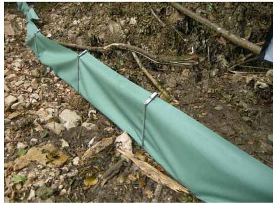
Photos 19 et 20 : Un exemple, en cours de montage sur la voie RN 57 des Mercureaux (en 1999) de « kit » de dispositif de protection temporaire qui comprend une bâche polyester de 50 cm de large, des piquets ajustables en hauteur, des éléments de fixation cousés (45°) en partie supérieure pour former un bavolet infranchissable à placer tous les 2 m (Source : © M. Gignoux, Cerema Est)
