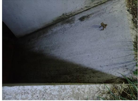
Photos 46 : Batrachoduc de Gaumont : la pente est un peu « raide » au point que le Parc naturel régional de Lorraine, l'un des porteurs du projet, a dû poser du géotextile sur les traversées les plus fréquentées par les amphibiens
