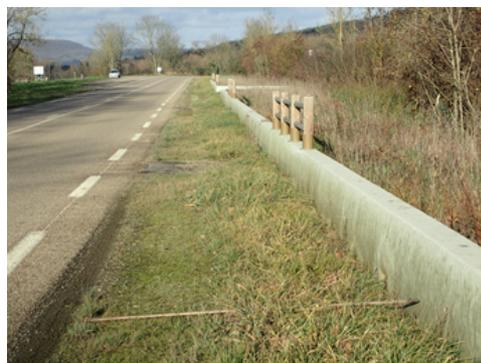
Photos 49 et 50 : Mur Véhicule Léger en bordure de chaussée
