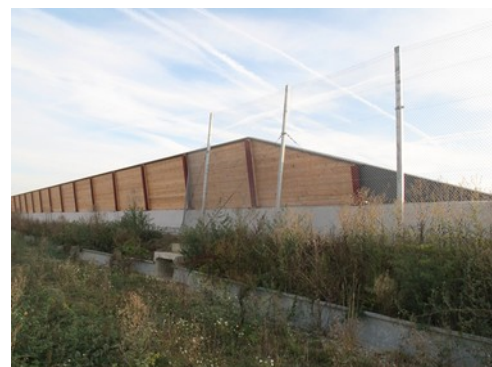
Illustration 13: grillage et mur antibruit (source : Cerema)
