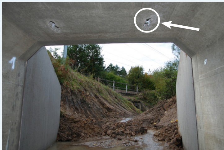
Photo 105 : Deux réservations ont été créées d'une profondeur d'une quinzaine de cm, de 20 cm de longueur et de 15 mm de largeur pour l'une et de 20 mm de largeur pour la seconde (Source : L. Arthur - Muséum Bourges)
