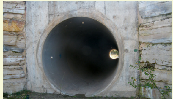
Photo 47 : Buse de diamètre 2,20 m
