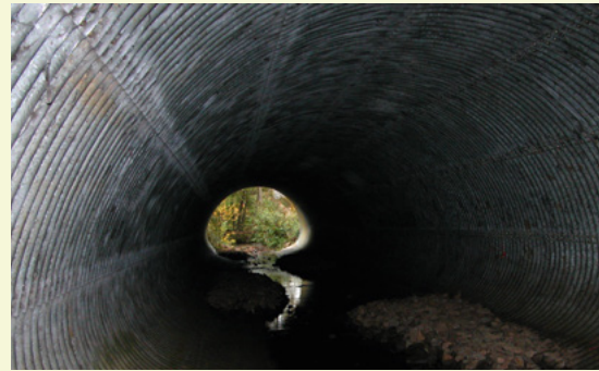
Photo 46 : Buse métallique de diamètre 2 m (Source : Cerema - Est)
