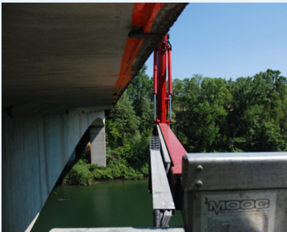
Photo 135 : Opération d'entretien sur un ouvrage d'art (Source : Sophie Bareille)
