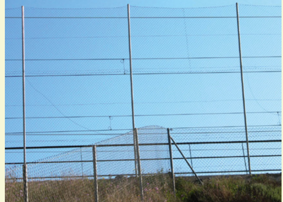
Photos 69 et 70 : Grillage anti-collision de 4 m de haut installé de part et d'autre des voies LGV (Source : ADIF High Speed)
