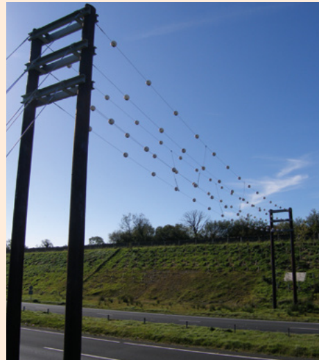
Photo 34 : Portique type (Source : Altringham)
