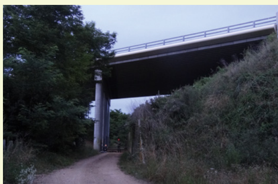
Photo 144 : zone de franchissement de l'A406 par les pipistrelles (Source : Cyberio)
