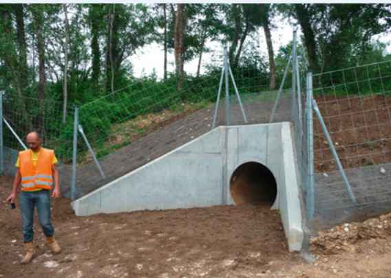
Photo 123 : Eco-duc sur A10 (Source : Naturalia/Vinci Autoroutes/réseau ASF - 2012)
