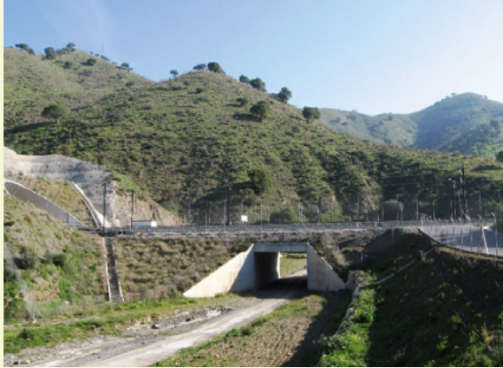
Photos 69 et 70 : Grillage anti-collision de 4 m de haut installé de part et d'autre des voies LGV (Source : ADIF High Speed)
