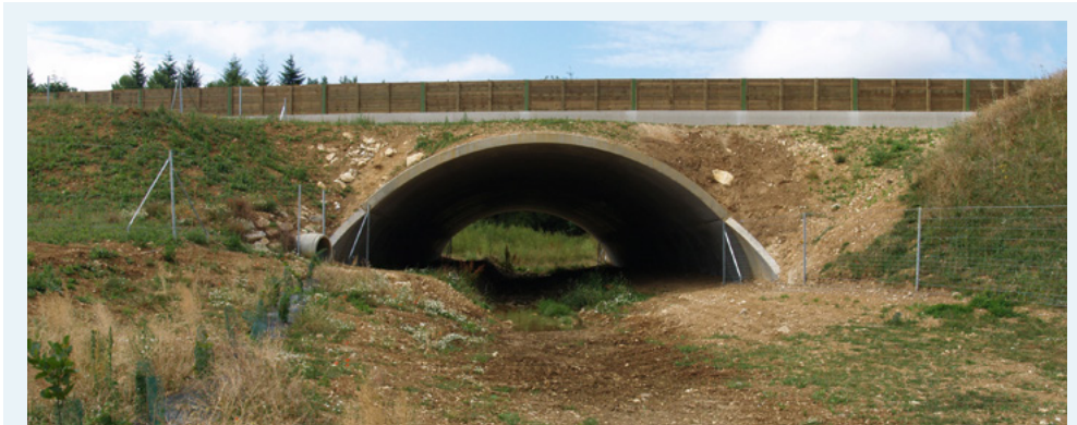
Photo 49 : Ouvrage inférieur de l'autoroute A88 équipé d'un écran d'occultation (Source : Groupe mammologique Normand)
