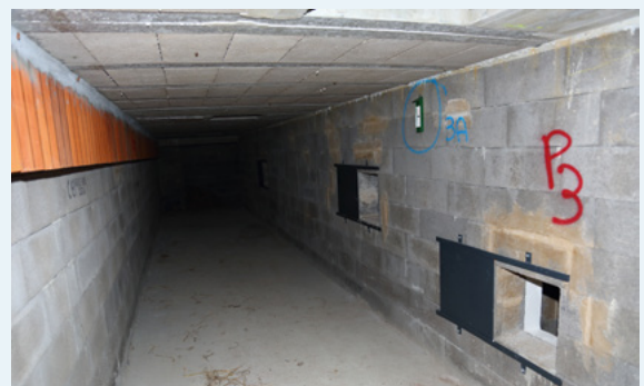
Photo 95 : Ouvertures de régulation thermique (Source : CPEPESC Lorraine)
