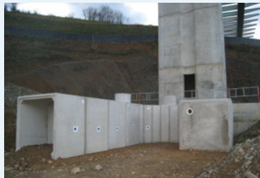
Photos 88, 89, 90 : Galerie artificielle construite au pied de la pile d'un viaduc
