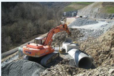
Photos 91 et 92 : Galerie artificielle construite dans un remblai
