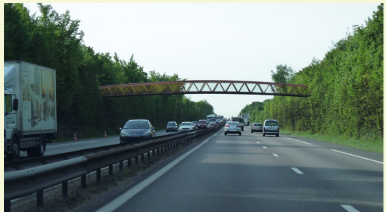
Photo 28 : Passerelle pour piétons sur l'A33 (Source : Cerema - Est)
