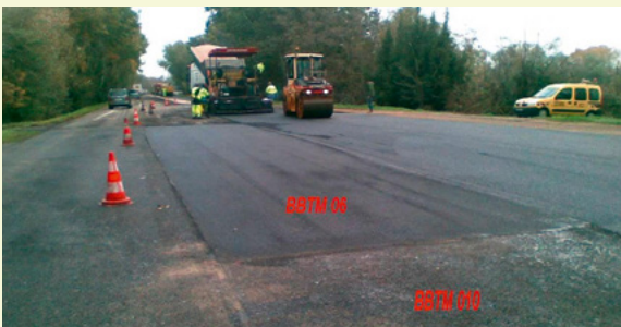
Photo 20 : La pose du BBTM a été intégrée dans une opération de rénovation déjà programmée (Source : CD 13/Groupe Chiroptères de Provence)
