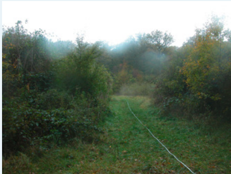
Photo 61 : Tablier végétalisé permettant une bonne connexion entre les habitats situés de part et d'autre de l'ouvrage supérieur (RN57 - Lorraine) (Source : Cerema - Est)
