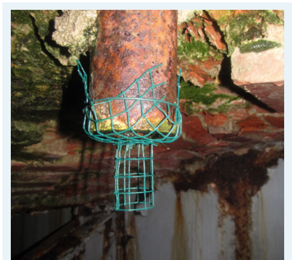
Photo 17 : Exemple de dispositif anti-retour utilisé dans le cadre de la réfection d'un ouvrage d'art (Source : CPEPESC Franche-Comté)
