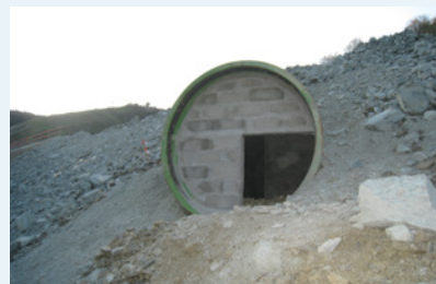
Photos 91 et 92 : Galerie artificielle construite dans un remblai
