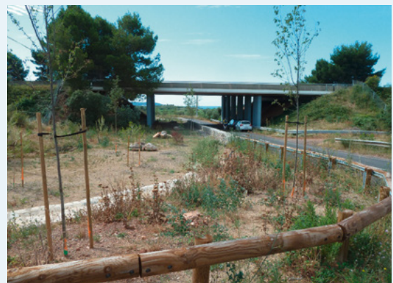
Photo 121 : Conversion d’un ouvrage inférieur en passage mixte sur l’autoroute A9 (34) (Source : Écologistes de l’Euzière / Vinci Autoroutes/réseau ASF 2012)
