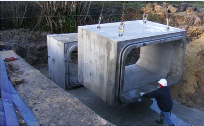
Photo 104 : Mise en place des modules préfabriqués
