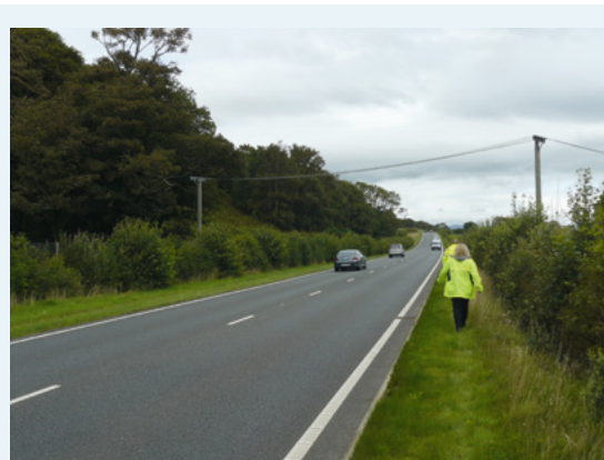
Photo 33 : Exemple de structure (fils tendus, grillage) mise en œuvre sur le réseau routier hollandais (Source : A & W Ecologisch onderzoek)
