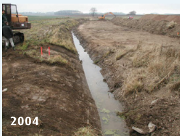
Photo 58 : Réhabilitation d'un cours d'eau - Phase travaux (Source : Gabriele Hintemann/Plan T)
