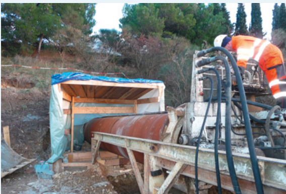
Photo 122 : Fonçage d'une buse sur A7 (Source : Vinci Autoroutes/réseau ASF - 2010)
