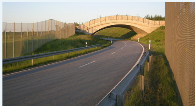
Photo 67 : Exemple allemand de clôtures de 4 m mises en place de part et d'autre de la voie (Source : Kathi Märki/ NACTaktiv & SWILD)
