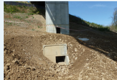
Photos 88, 89, 90 : Galerie artificielle construite au pied de la pile d'un viaduc
