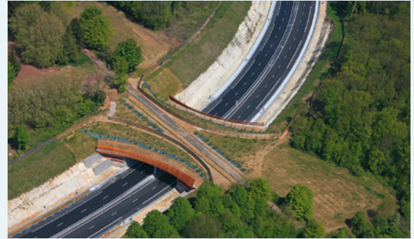
Photo 65 : Aménagement d'un passage mixte sur la RN17 (Source : DIR Nord)
