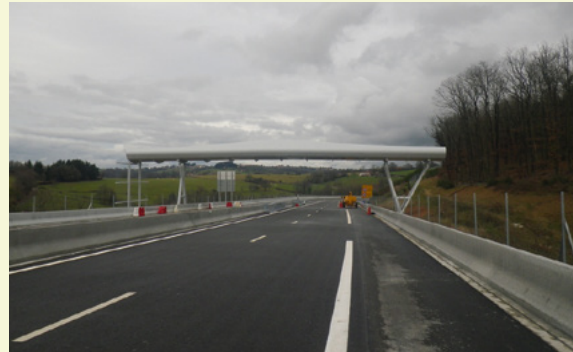
Photo 41 : passerelle à chiroptères de l'autoroute A89 Tour de Salvigny - Balbigny (Rhône Alpes) (Source : Vinci Autoroutes/réseau ASF - Baudin Châteauneuf - Kristen, 2012)
