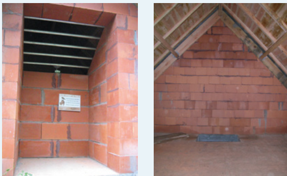
Photos 85, 86, 87 : Gîte construit pour l'accueil des Grands rhinolophes
