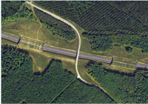
Illustration 51 : Tranchée couverte de l'A19 Courtenay - Artenay dans la traversée de la forêt de Montargis (Source : IGN)
