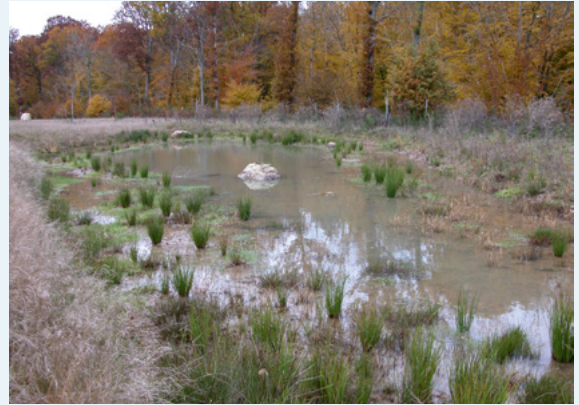
Photo 25 : Reconstitution d'une zone humide au droit de la tranchée couverte (Source : Cerema - Est)
