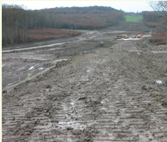
Photo 2 : Chantier LGV Rhin-Rhône. Les travaux peuvent conduire au défrichage de vastes emprises forestières (Source : Cerema - Est)
