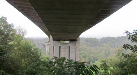
Photo 129 : Viaduc de l'A64 (Source : Vinci Autoroutes/réseau ASF)
