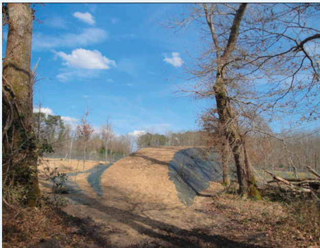
Photo 32 : A65 – Tremplin vert conduisant à un passage spécifique (cf. chapitre f - Passages supérieurs « légers ») (Source : Eiffage TP)
