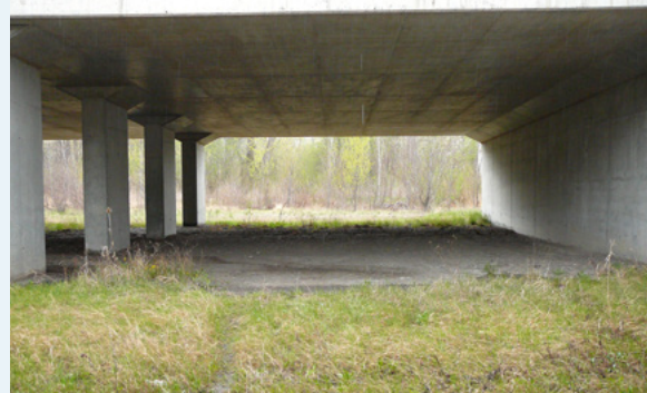
Photo 109 : Ouvrage de franchissement permettant d'accéder à la zone de compensation (Source : Eliane Dupland)
