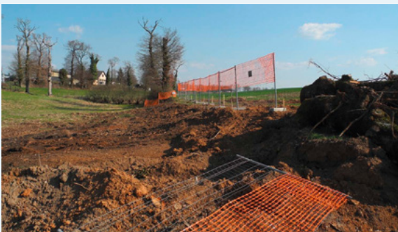
Photo 74 : Dispositif de guidage provisoire en phase chantier sur la RN 88 dans le Tarn et l'Aveyron (région Midi-Pyrénées) (Source : Sophie Bareille - CREN MP)
