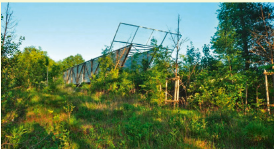
Photos 39 (Source : Aliénor/Eiffage TP) et 40 (Source : E. Cosson/ Groupe Chiroptères de Provence) : Ouvrage de l'autoroute A65 (Pau-Langon)
