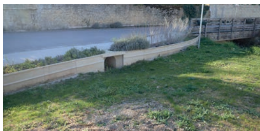
2 Bordure en béton polymère. Source : Commission Environnement, Commune d'Ahuy.
