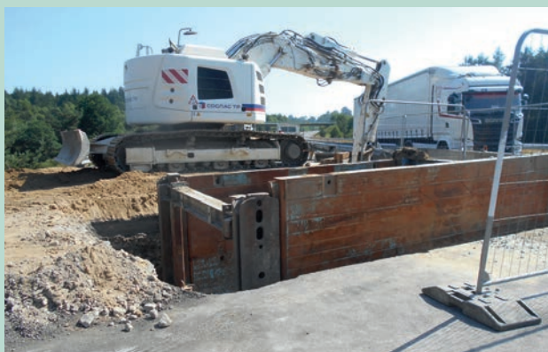
Ouverture de la chaussée et blindage de la tranchée.
