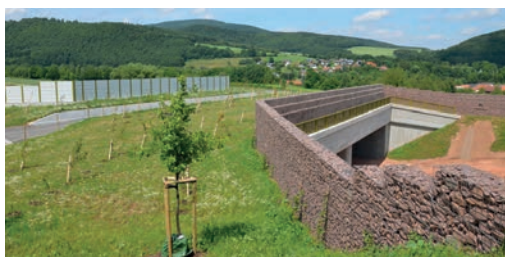
14 Mur en gabion sur un passage allemand. Source : Christine Henn, Mobil Hessen.
