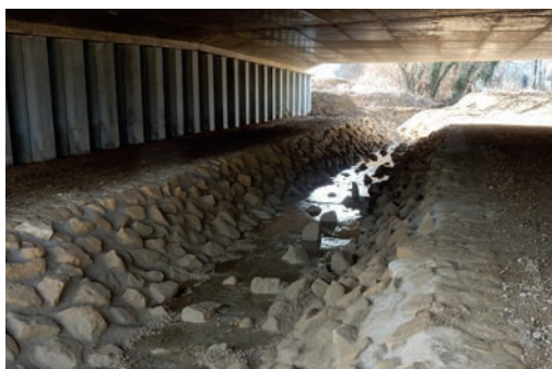
Rétablissement d'un cours d'eau sous l'ouvrage avec berges maçonnées. Source : Cerema.
