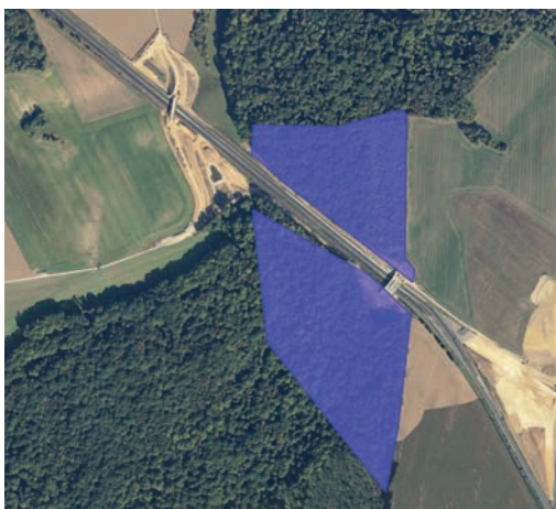
27 Mesure compensatoire aux abords du passage faune. Prolongement de l'autoroute A16 sur le réseau SANEF. Source : Geoportail.
