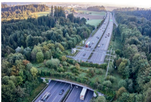
4 Exemple de passage remarquable toute faune sur l'autoroute A1 en Suisse. Source : AURA/Emanuel Ammon.
