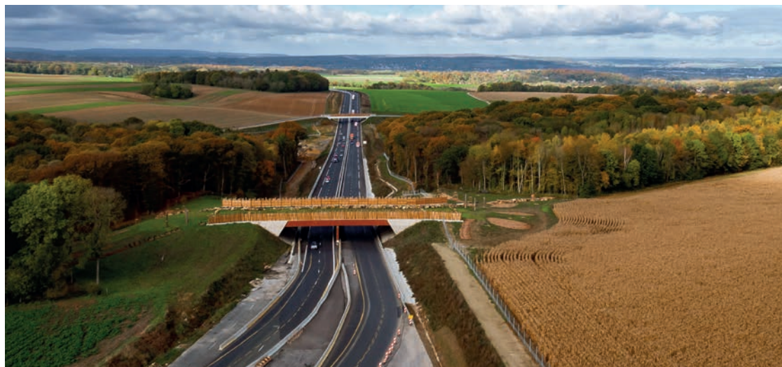
❶ Ouvrage supérieur sur l'autoroute A16. Source : Sanef.
