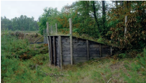
Échappatoire avec un système de rampe simple (Pays-Bas). Source : Vinci Autoroutes.
