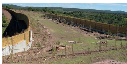
18 Dispositif de chicanes installé sur le passage supérieur de l'autoroute A57. Source : Jean Carsignol.
