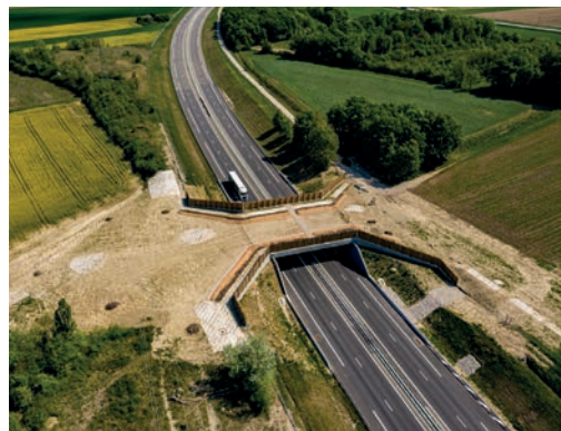
1 Passage supérieur équipé d'une culée en mur de front. Source : ATMB - Arnaud Lesueur.
