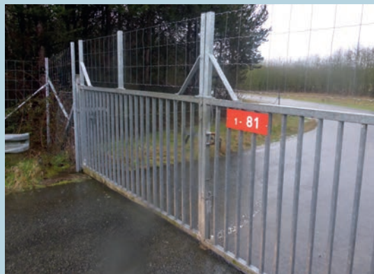
Rehausse sur portail de service. Source : Cerema.
