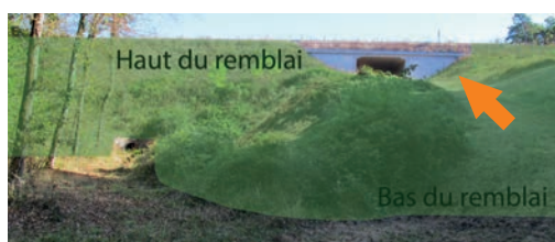
Passage inférieur positionné en haut du remblai. Source : Cerema.
