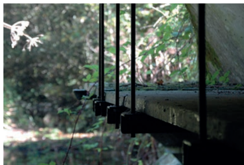
❸ Banquette avec platelage en béton de 40 cm de largeur sur 50 m de long et un tirant d'air de 60 cm. Coût : 6 000 € (pose en régie). RN164 (DIRO). Source : Cerema.
