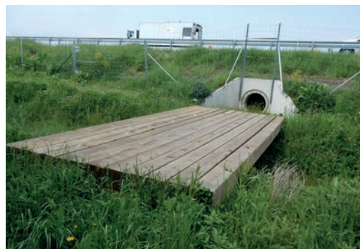
⑫ Dispositif de franchissement d'un fossé de type plateforme en bois. Source : Cerema.
