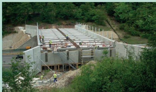
Passage en phase travaux. Source : Vinci Autoroutes/réseau ASF.
