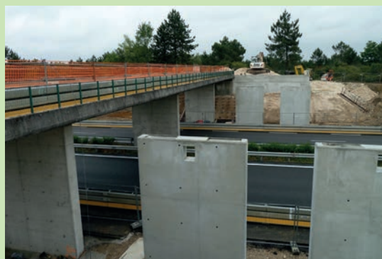
③ Vue sur les piles. Source : ASF/Vinci Autoroutes.
