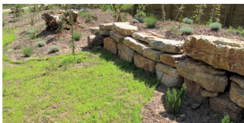
13 Muret en pierres sèches. Autoroute A8. Source : Jean Carsignol.
