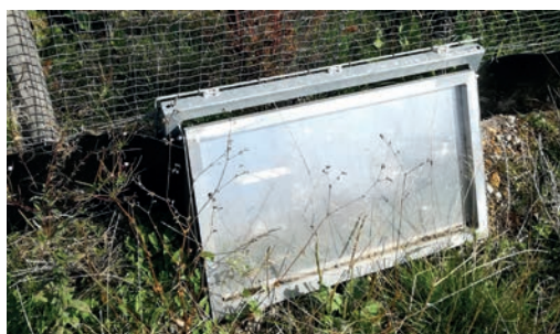
23 Échappatoire petite faune aux Pays-Bas. Source : Cerema.
