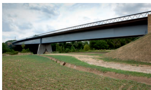
❶ Ouvrage métallique. Source : Matière TP.
