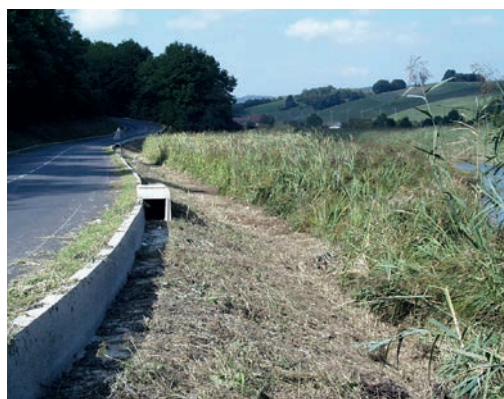
Entretien du passage à amphibiens de la réserve nationale du Grand Lemps. Source : Cerema Centre Est - V. Billon.
