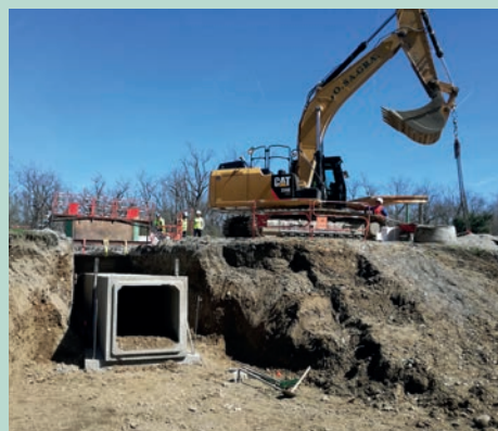
Mise en œuvre des éléments de l'ouvrage. Source : TEC INFRA/Bureau d'études VRD & Maitrise d'œuvre.
