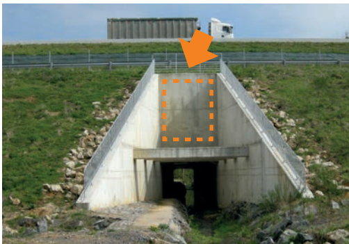
24 Ouvrage du ruisseau d'Olzey. RN 59 (54). Source : Cerema.
