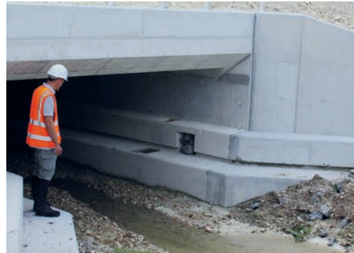
17 Exemple d'abris créés dans la bannette faune d'un ouvrage. Source : Michel Bramard OFB.
