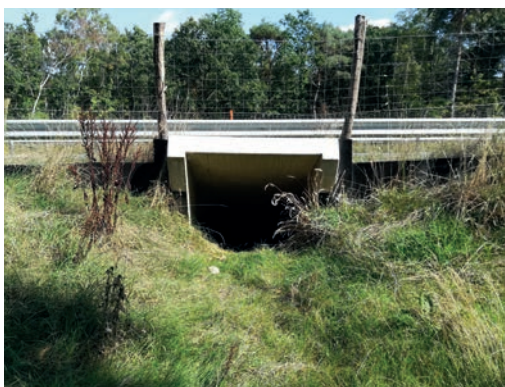
Passage petite faune en pente sur une infrastructure située au niveau du terrain naturel. Source : Cerema.
