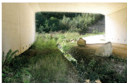
Passage inférieur dont les usages sont séparés par des blocs et le passage d'un cours d'eau (Autoroute A34). Source : Cerema.
