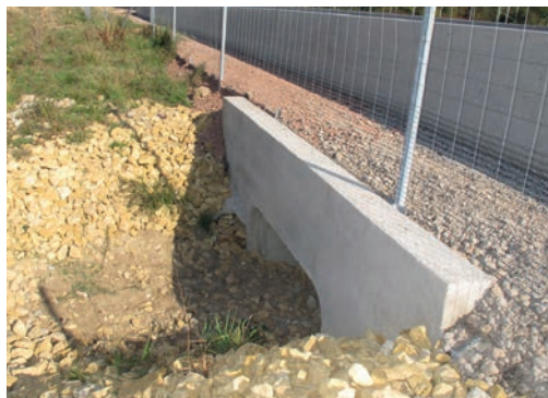
❺ Fosse d'entonnement au droit d'un passage petite faune d'une section d'infrastructure située au niveau du terrain naturel. RD 16 (CD57). Source : Cerema.
