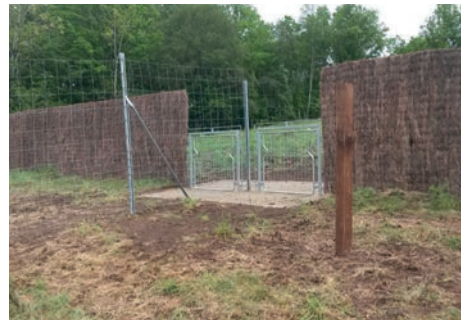
Trappe accompagnée d'une clôture guide. Source : Vinci Autoroutes/Réseau ASF.
