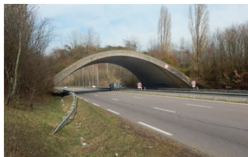
5 Pont en Arc. RD 31, Moselle. Source : Cerema.
