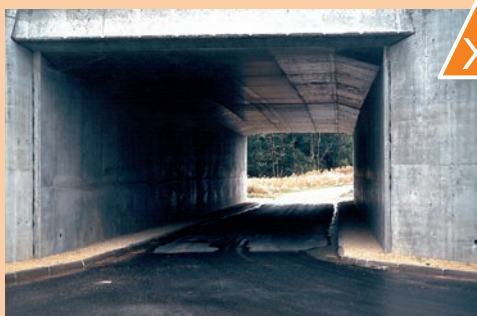
Exemple d'un ouvrage mixte faune et rétablissement forestier dont le chemin a été revêtu et dans lequel les bandes enherbées ont été remplacées par des trottoirs.
