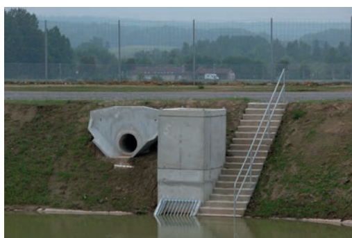
(20) Bassin de traitement équipé de clôtures amphibiens. Source : Cerema.
