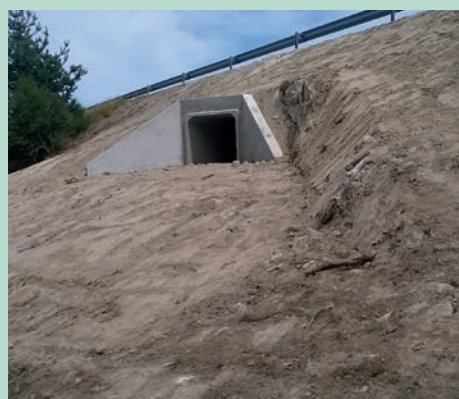
Ouvrage finalisé avant la pose de la clôture.
