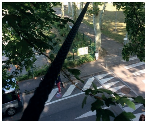
Corridor équipé d'un pont de singe pour rétablir la liaison en canopée. Source : Julien Soret - Métropole du Grand Nancy.
