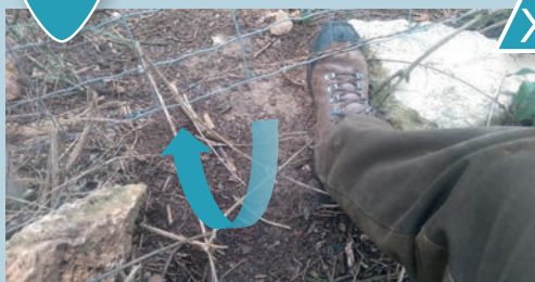
Point d'entrée dans les emprises sur une section de grillage non brochée. Source : Mathieu Narce, IMPCF.
