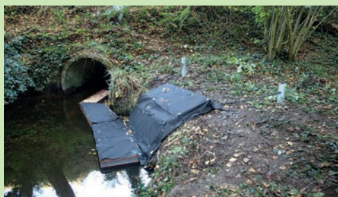
Raccordement du Ponton à la berge. Source : GREGE.
