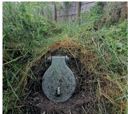
13 Clapet antiretour sur descente d'eau empêchant la faune d'accéder aux emprises. Source : P. Fournier, GREGE.
