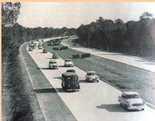
Autoroute A6 dans la traversée du massif de Fontainebleau en 1963. Source : Archives nationales, WikiSara.
