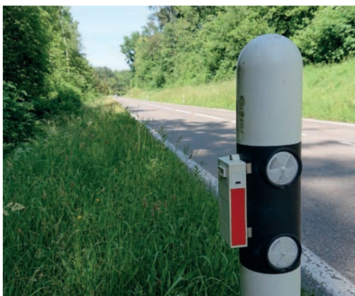
Dispositif acoustique fixé aux poteaux et déclenché par la lumière d'un véhicule qui s'approche.
