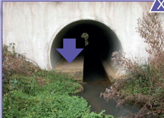
14 Présence d'une marche à l'entrée du passage limitant l'accès aux plus petites espèces. A34 Reims, Charleville-Mézières. Source : Cerema.
