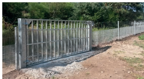
5 Portail équipé d'un seuil béton. Source : Vinci Autoroutes/Réseau ASF.
