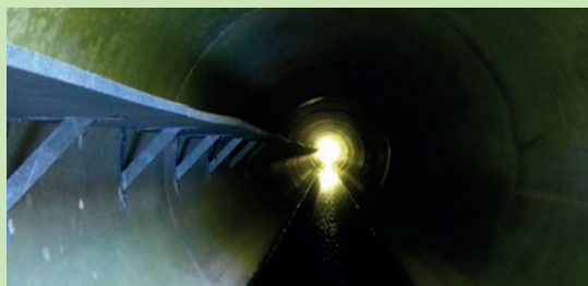
Banquette en plastique recyclé de 50 cm de largeur sur 65 m de long et un tirant d'air de 70 cm. Coût : 15 000 € TTC (2013). RN137 (DIRO). Source : Cerema.
