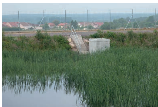
(20) Bassin de rétention accessible aux amphibiens. Source : Cerema.
