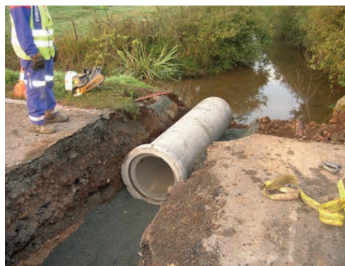
Installation de buses sèches dédiées à la loutre. Source : François Varenne.
