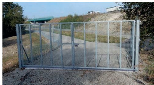
4 Portail équipé d'une « jupe ». Source : Cerema.
