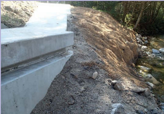
18 Aménagement au sein de la bannette faune d'un cheminement pour les micromammifères*. Source : P. Fournier GREGE.
