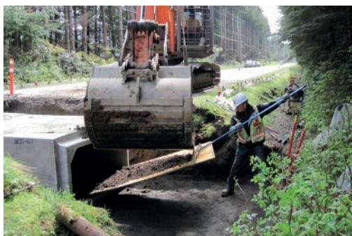
Mise en œuvre d'une couche de matériaux naturels. Source : Barb BEASLEY, Association of Wetland Stewards for Clayoquot and Barkley Sounds.
