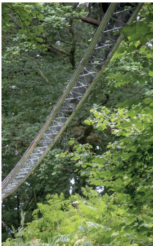
Passage canopée à structure métallique. Source : Animex.
