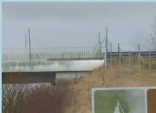
Retour sur ouvrage d'art. Source : Cerema.
