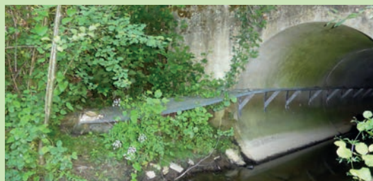
Banquette en plastique recyclé de 50 cm de largeur sur 65 m de long et un tirant d'air de 70 cm. Coût : 15 000 € TTC (2013). RN137 (DIRO). Source : Cerema.
