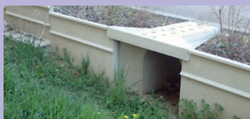
Ouvrage de franchissement ajouré. Source : Commission Environnement, Commune d'Ahuy.
