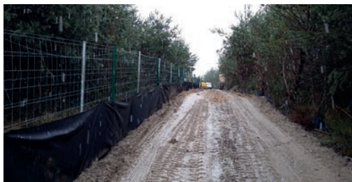
Piste d'accès chantier. Source : ASF/Réseau Vinci Autoroutes.
