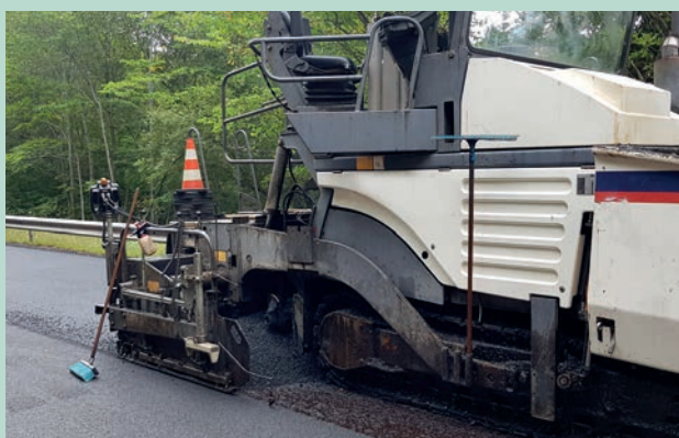
Reprise de l'enrobé. Source : Cerema.
