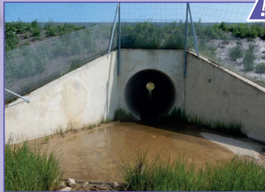
23 Ouvrage inondé limitant le passage de certains animaux au moins une partie de l'année. Source : Cerema.
