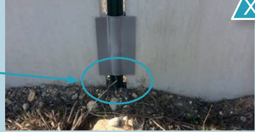
Ouverture dans le dispositif constituant un point d'entrée. Source : Cerema.
