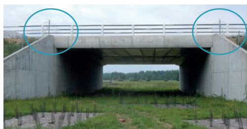
Clôture longeant les murs en retour et raccordée à la rambarde de l'ouvrage. Source : Cerema.
