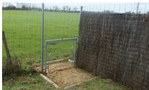
22 Échappatoire, réseau Vinci Autoroutes. Source : Cerema.
