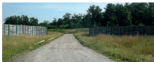
Barrières en bois installées le long du chemin pour éviter aux véhicules d'accéder à l'espace réservé à la faune. Source : Cerema.
