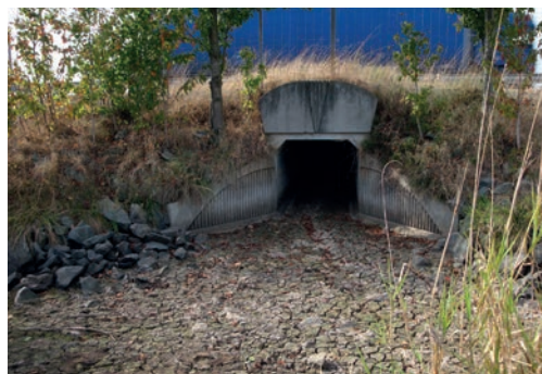
16 Tête d'ouvrage avec des murs ouverts. Source : Cerema.
