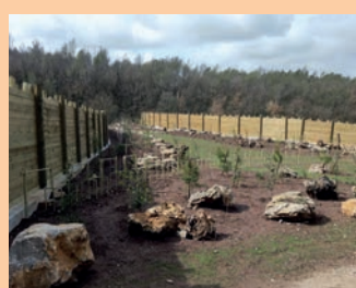
Mise en œuvre des écorestanques « en série ». Autoroutes A8 et A57. Source : C. Buton, Cabinet X-Aequo.
