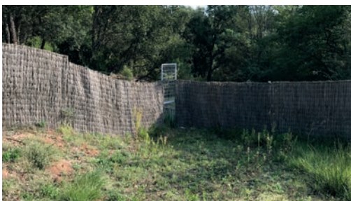
27 Système « Sangli-pass » installé dans un coin de la clôture. Source : Cabinet X-Aequo.
