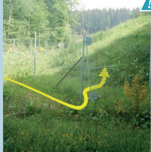
Ouverture dans la clôture laissant l'accès aux emprises. Source : Cerema.
